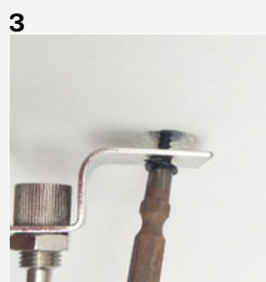
3 固定金具を天井面に取り付ける
