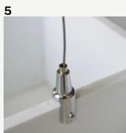
5 ワイヤーの接続金具を吸音パネルに取り付ける
