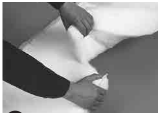
図3 長さ調整は手でも可能です。耳部分は、刃物でカットして下さい。
